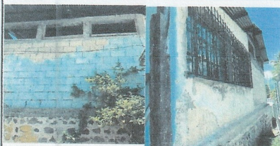
Foto 5: Las infraestructuras de la parte de afuera del aula se encuentran deterioradas porque la mayor parte está construida de adobe. Es aquí en la misma parte exterior que se necesita de aplicar pintura
